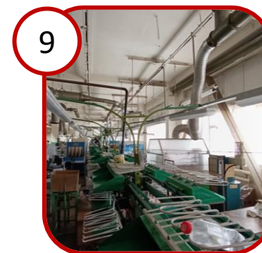
3 этаж цех пошива заготовок
